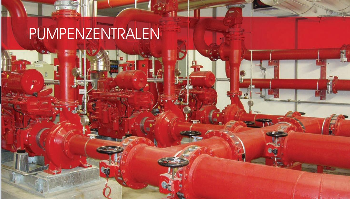
Die Pumpenzentrale ist das Herzstück einer jeden stationären Löschanlage. Hier wird der erforderliche Druck für das Löschwasser und die nachgeschalteten Löschbereiche bzw. die Löscheinheiten erzeugt.
