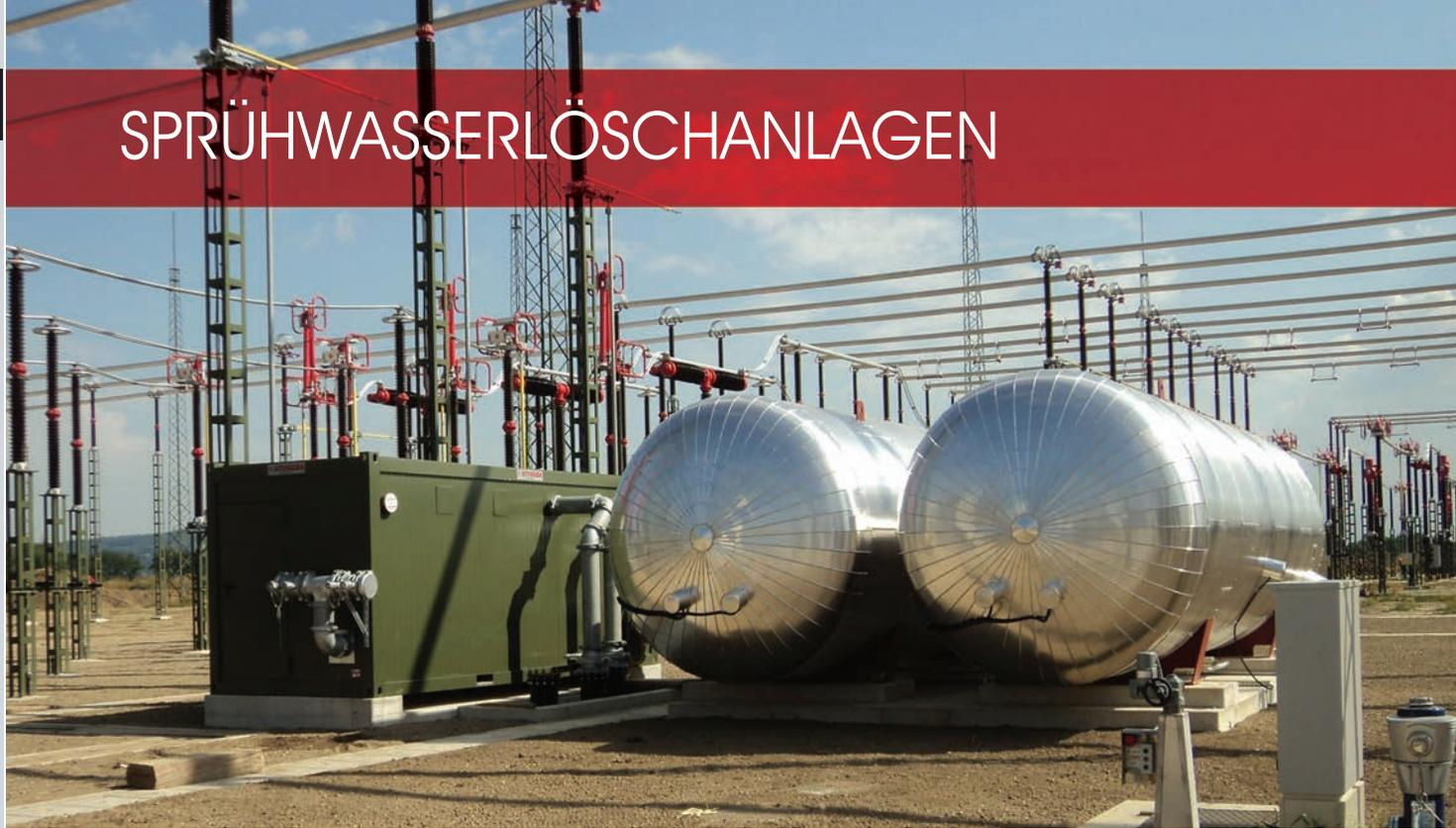
Sprühwasserlöschanlagen schützen Objekte und Räume, wo mit einer schnellen Brandausbreitung zu rechnen ist. Während mit Sprinkleranlagen bei Bedarf Löschwasser selektiv über dem Feuer abgegeben wird, können mit Sprühwasser- bzw. Sprühflutanlagen größere technische Objekte flächendeckend besprüht, gekühlt und somit geschützt werden. Zudem bietet die rauchgasreinigende Wirkung im Brandfall hervorragenden Personenschutz.
