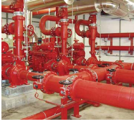
Sprinkler-Pumpenzentrale
