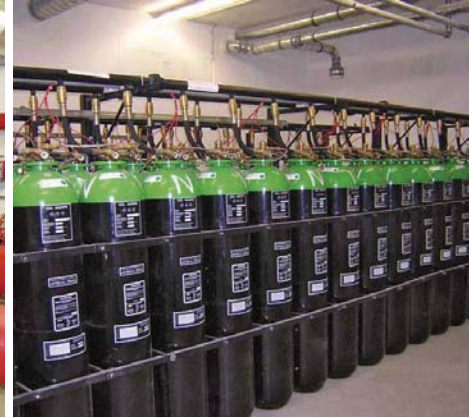
Gaslöschanlage
